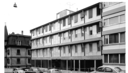
MFH Morillonstrasse, Bern (Projekt: 1963, Fertigstellung: 1966)
