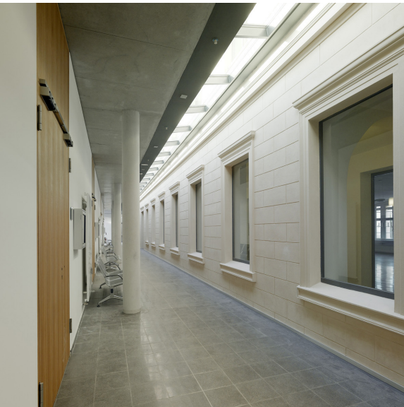
unten rechts: Fuge zwischen Alt- und Neu- bau artikuliert in Form eines umlaufenden Oberlichts
